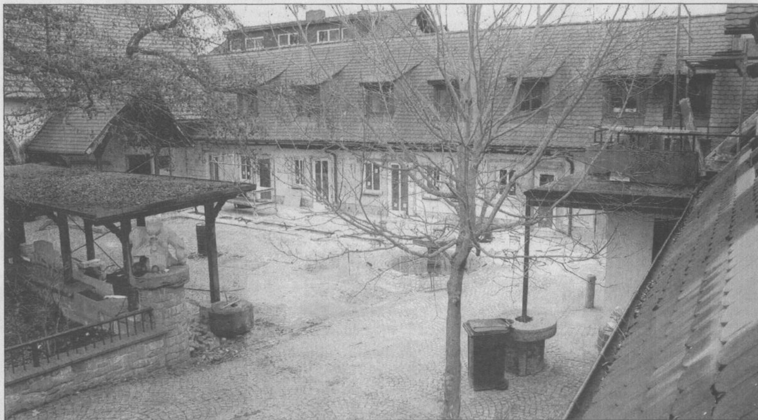
NOCH DOMINIEREN BAUARBEITEN auf dem Gelände der Neumühle in Speyer-Dudenhofen. Am 21. März eröffnet dort das erste Kinder-Hospiz im Rhein-Neckar-Raum. Das Betreuungsangebot soll zwölf Pflegeplätze umfassen. Foto: rndf
